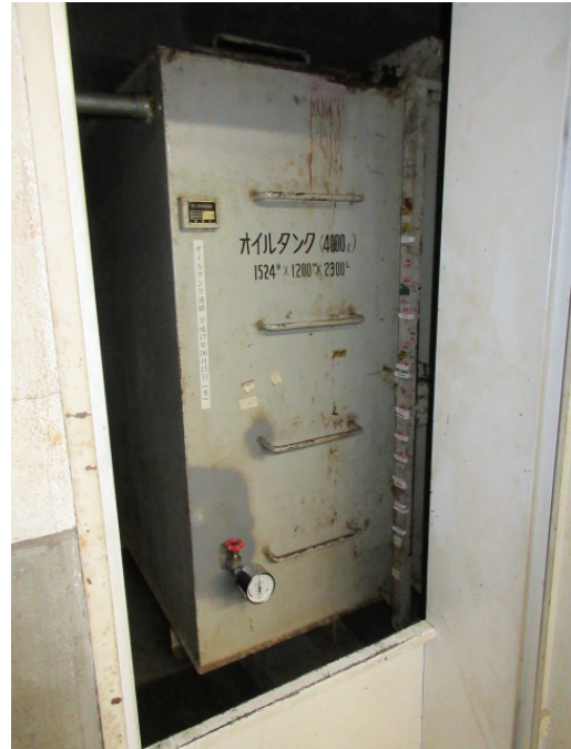
写真 19. 重油タンク室内部 今はオイルタンクが内蔵されている。 建築当時は石炭室。
