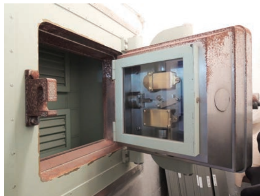
写真 16. 元金庫室 1 前室の人孔 扉の厚さは金庫室扉とほぼ同等。
