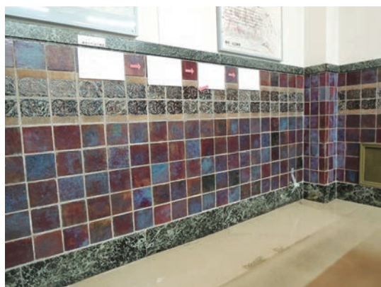
写真26. 腰壁タイルとその上下の石貼り
