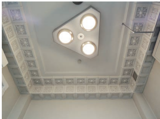
写真24. 2階支店長室天井 吹抜レベルの高さである。
