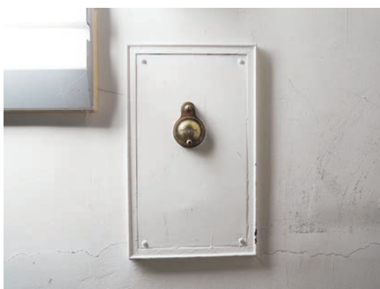
写真 10. シャッター操作装置（室内側） 真鍮製の丸いフタを 180 度回転させる（その途端 にシャッターが降りる）穴があり、その奥に引っ かける部分が確認できる。
