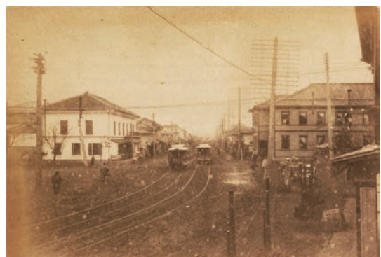
写真 2. 西側から見た初代建物（左側） （函館市中央図書館所蔵）
