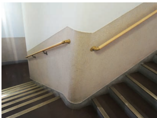
写真 39. 東側階段の腰壁 左官職人の手によるものと思われる。
