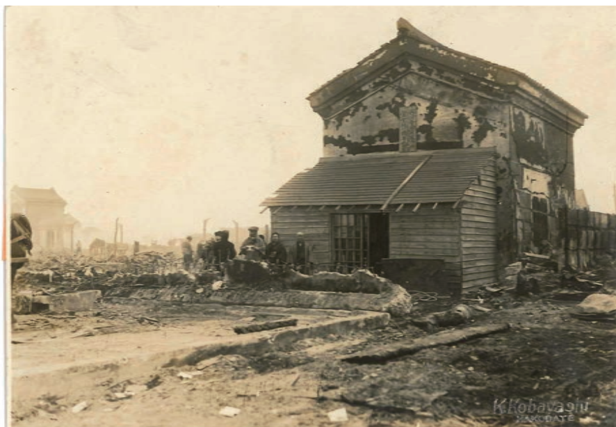
大火後の河合商店の1号倉庫（当館蔵 R06-0006）
