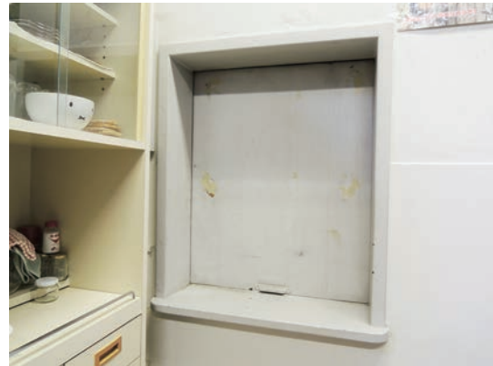
写真 22. 職員休憩室にある昇降機扉の痕跡
