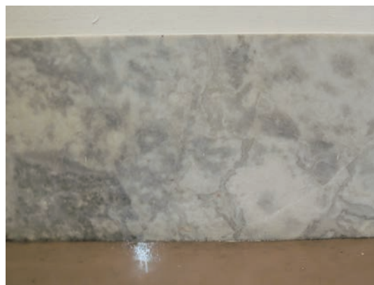
写真 30. VIP エリア廊下の幅木（展示室側）
