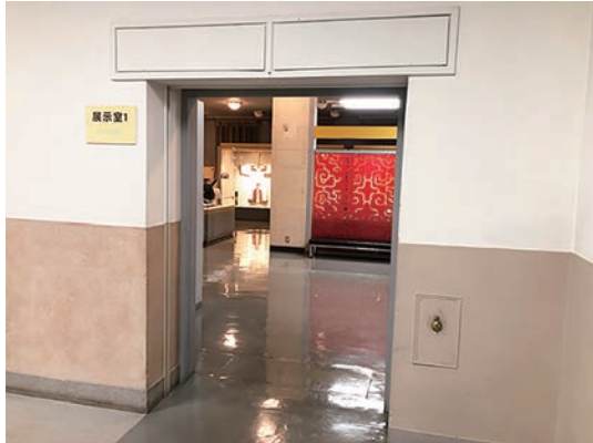
写真 21. 展示室 1 に入る部分のシャッター枠
