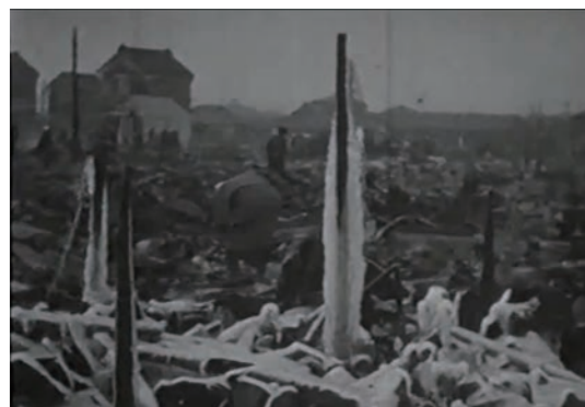
水道管の周りが凍り付いている （当館蔵 H05-0090）
