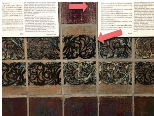
写真 41. 帯状にデザイン貼りされた2列のタイル赤い矢印のタイルだけが、下段で使われているタイルを逆さまに貼り付けられている。
