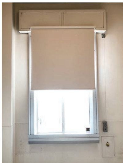
写真 9. 建物内部から見た窓 窓上部にはシャッター収納があり、右下には操 作用の装置が残存。室内の環境保全のため、窓に は現在ロールカーテンを設置している。
