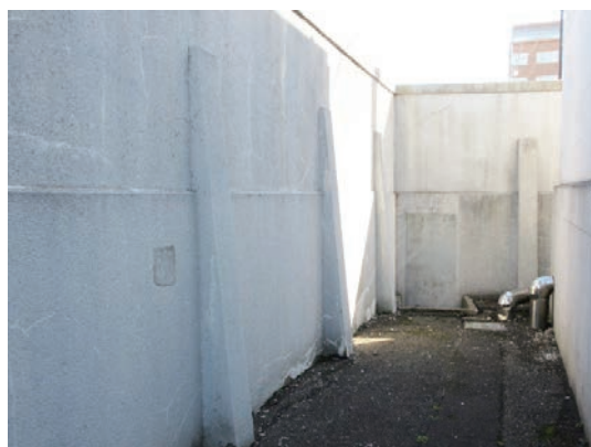
写真 11. 控え壁の付いた海側の塀（右は荷捌所）
