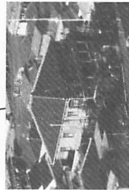
清国領事館 (明治25年3月着工)
