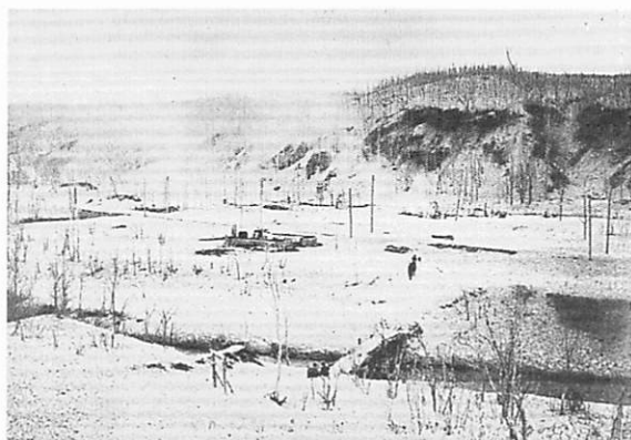
昭和4年6月の駒ヶ岳大噴火により降灰で埋没してしまった大沼電鉄線路留ノ澤付近と思われる。手前の川は折戸川か。【北海道景勝大観】より <市立函館図書館蔵>
