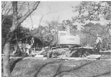
解体される店舗
